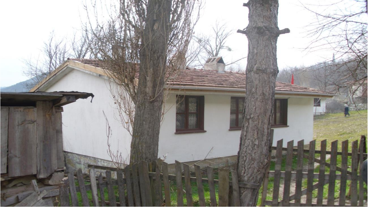
Mudurnu Yeniceşeyhler Köyü Sağlık Evi Tadilatı
