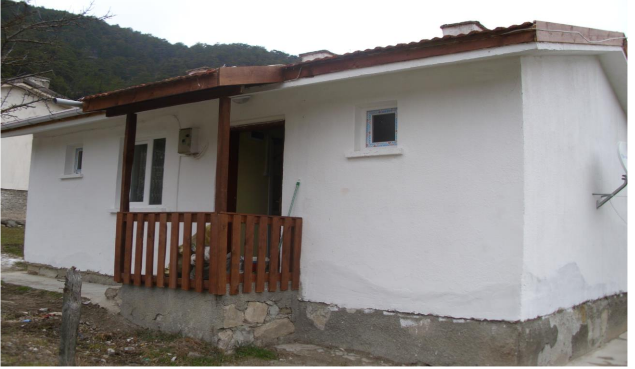
Mudurnu Cuma Köyü Sağlık Evi Tadilatı
