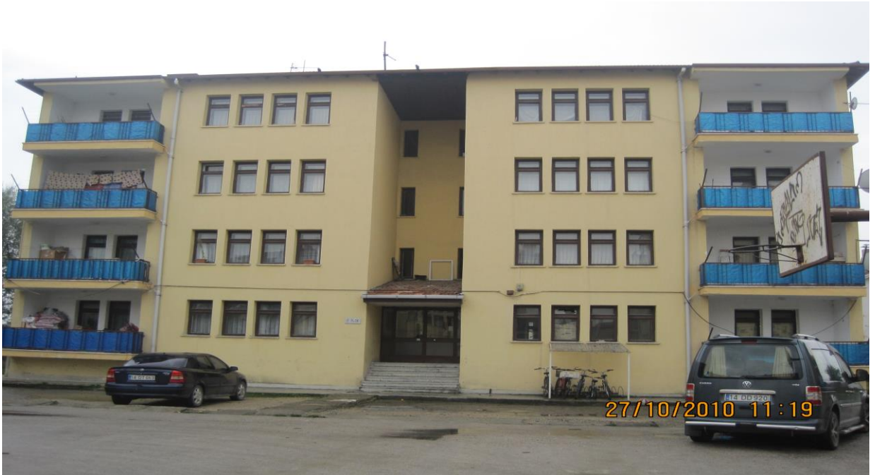
48 Konutlardaki Lojmanların Bakım ve Onarımı
