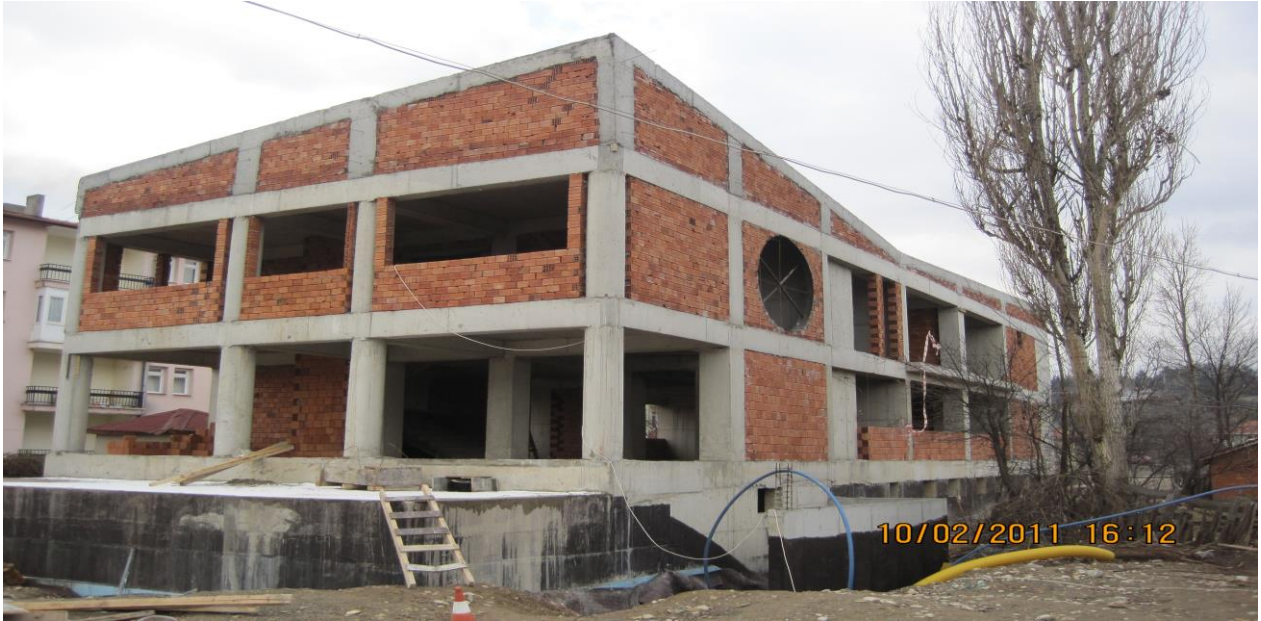
Mengen İlçe Emniyet Amirliği Hizmet Binası İnşaatı
