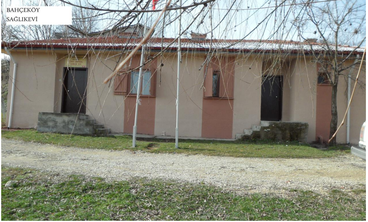
Bahçeköy Köyü Sağlık Evi Tadilatı
