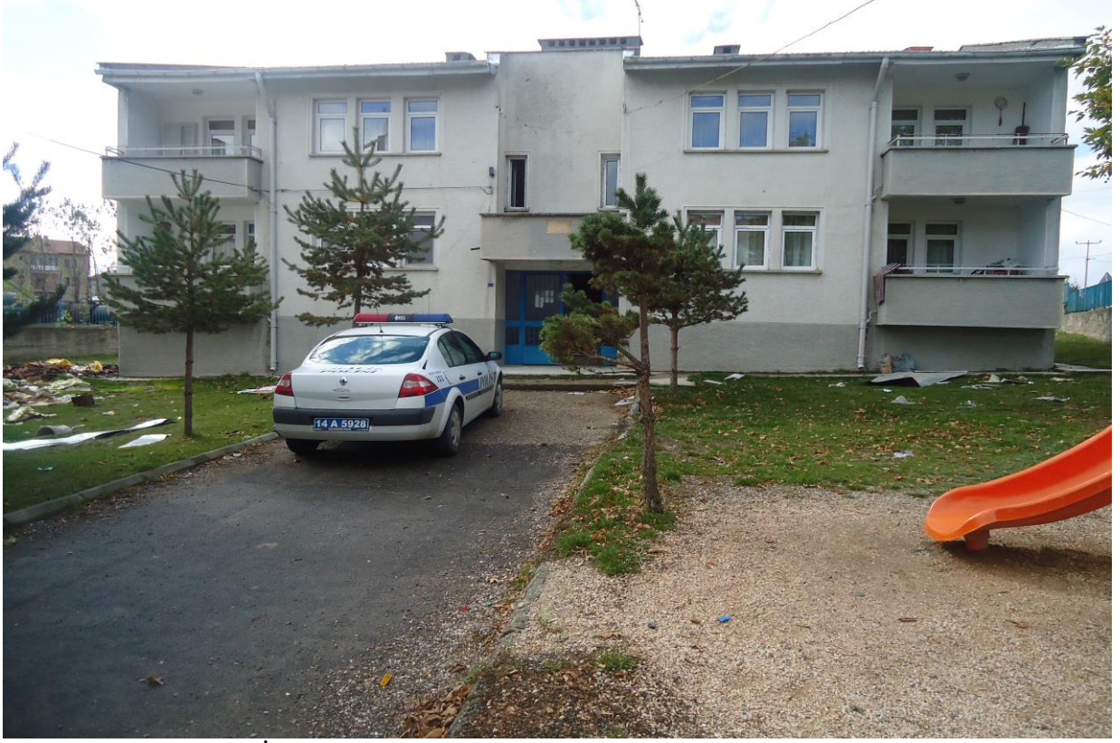
Gerede İlçesi Dayıoğlu Mahallesi Polis Lojmanları Tadilatı
