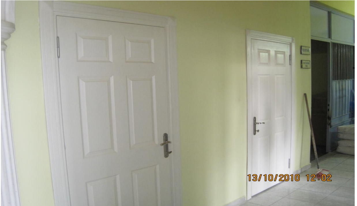
Yeniçağa İlçesi Gözaltı Merkezi Tadilatı
