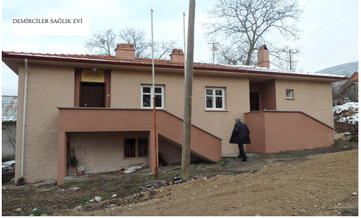
Demirciler Köyü Sağlık Evi Tadilatı
