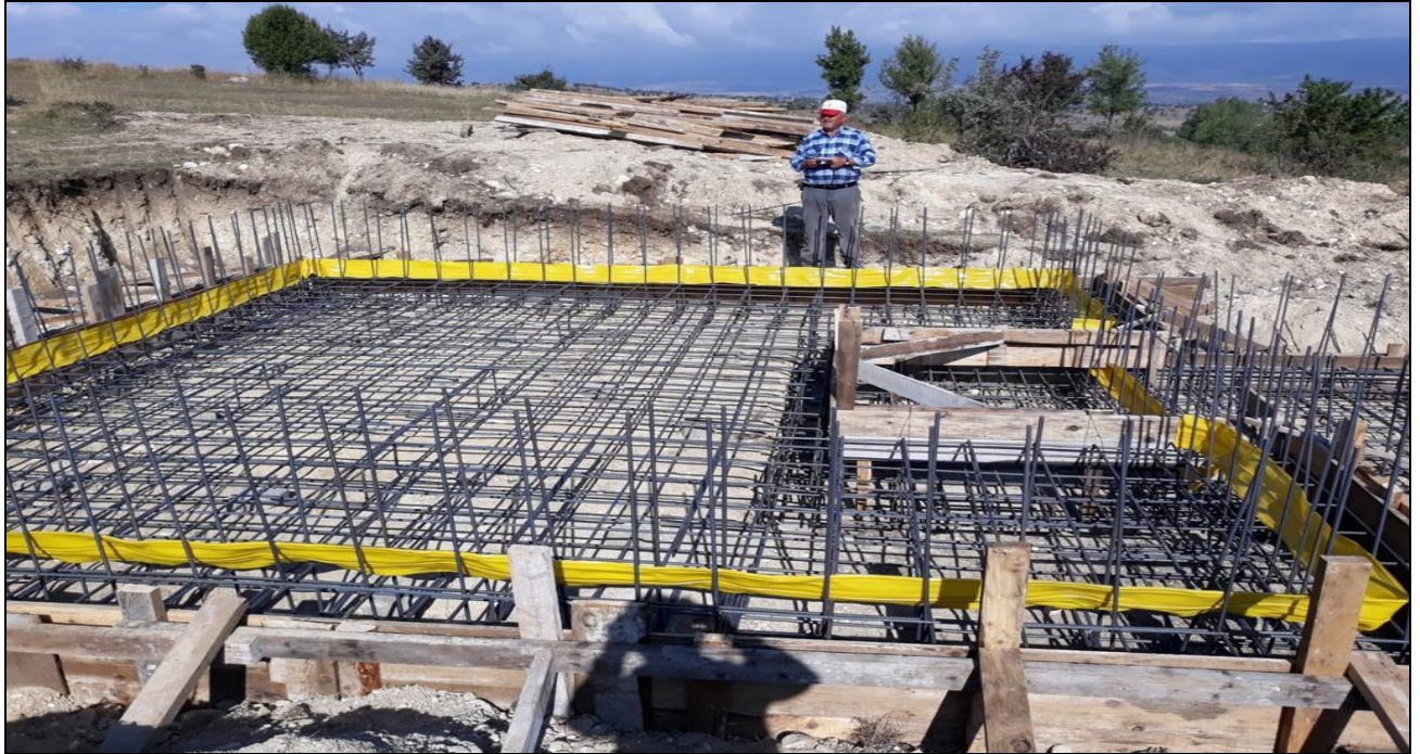
Yapımı Tamamlan İşlere Ait Görünüm
