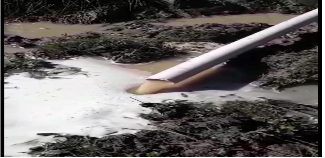
Mudurnu İlçe Özel İdare Hizmet Şantiyesi Sondaj Kuyusu İşlerinden Görüntü
