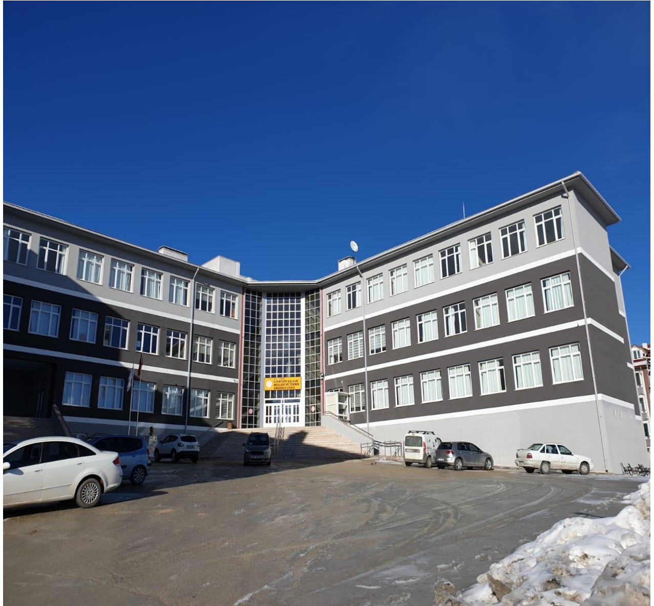
Gerede Aşçılar Mesleki ve Teknik A.L. ve 100 Öğrenci Kapasiteli Pansiyon Binası
