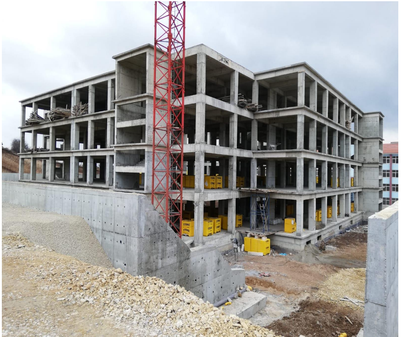
Mesleki ve Teknik Eğitim Anadolu Lisesi Atölye Binaları İnşaatı
