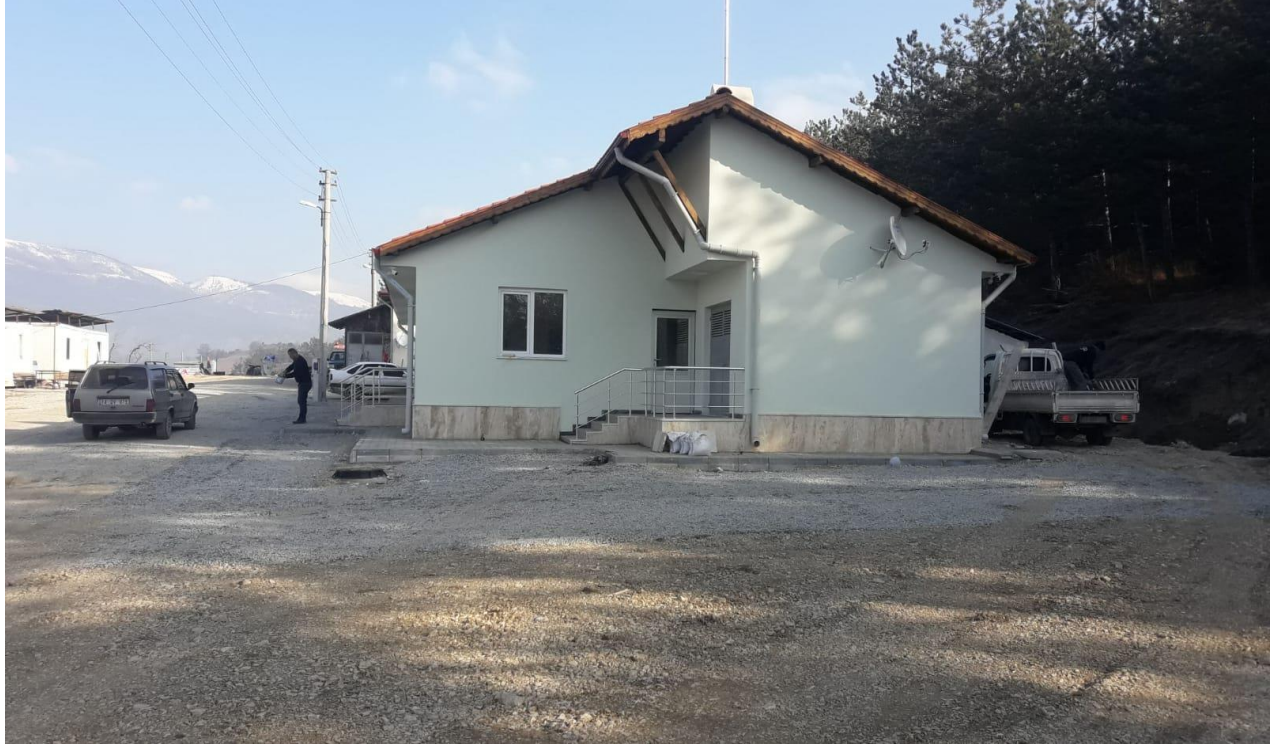
Mudurnu Şantiye Binası
