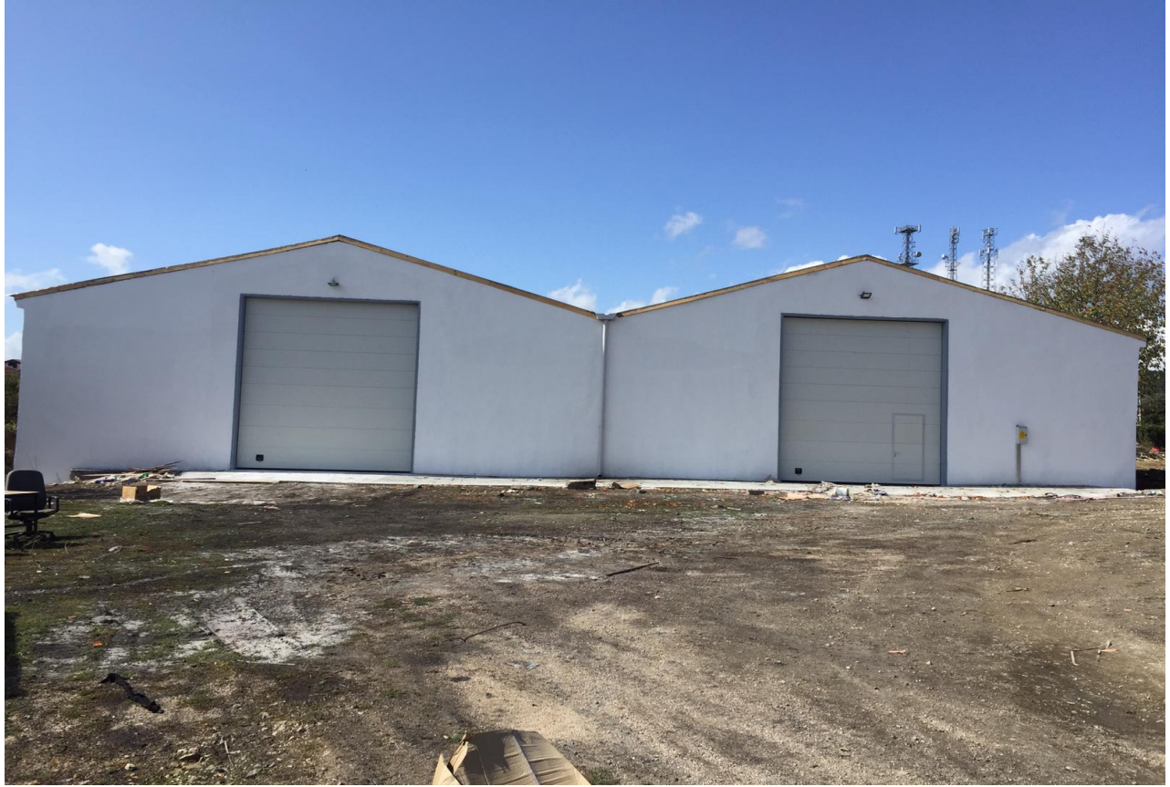
Acil Yardım Depolarının Bakım ve Onarımı
