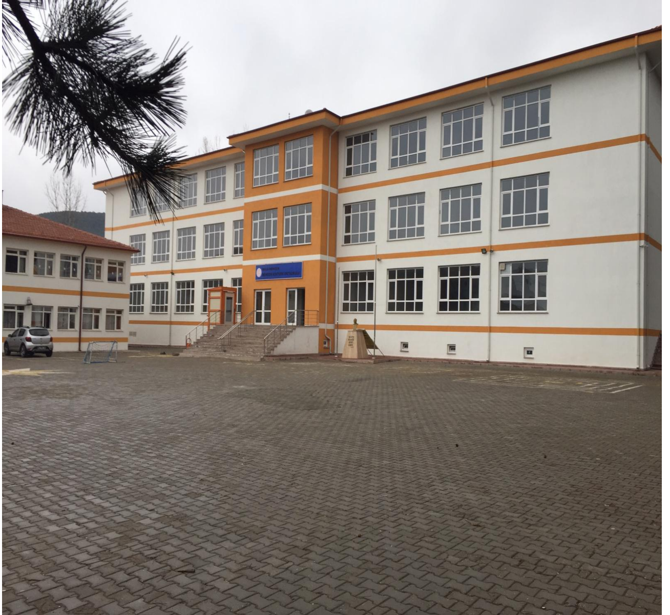
Mengen Atatürk Ortaokulu Binası
