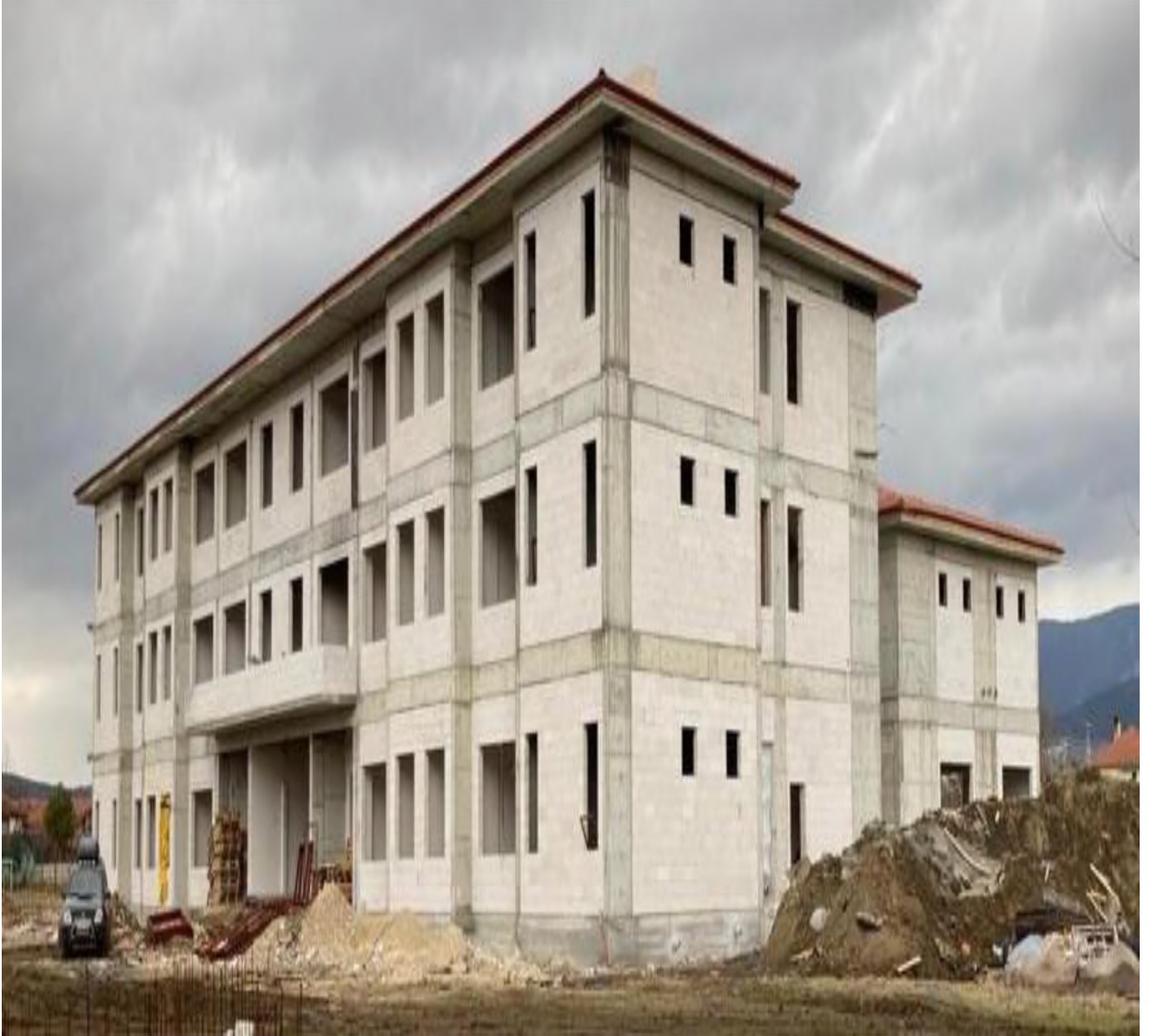
12 Derslikli Özel Eğitim Mesleki Eğitim Merkezi Binası
