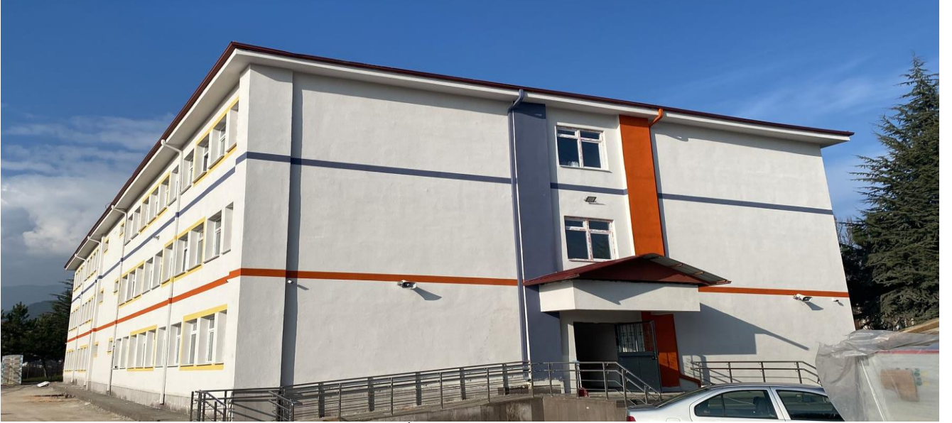
Behiye Baysal İlkokulu Güçlendirme ve Onarımı
