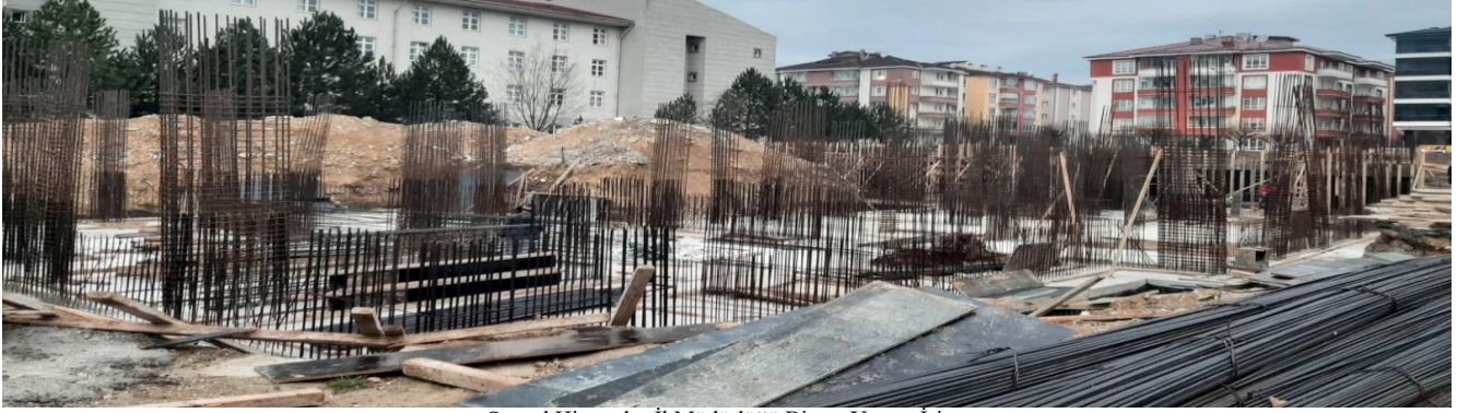
Sosyal Hizmetler İl Müdürlüğü Binası Yapım İşİ
