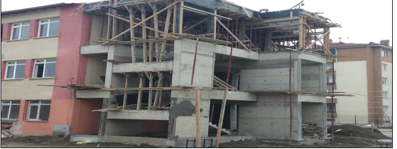
Bolu Merkez 60. Yıl Ortaokulu Binasi
