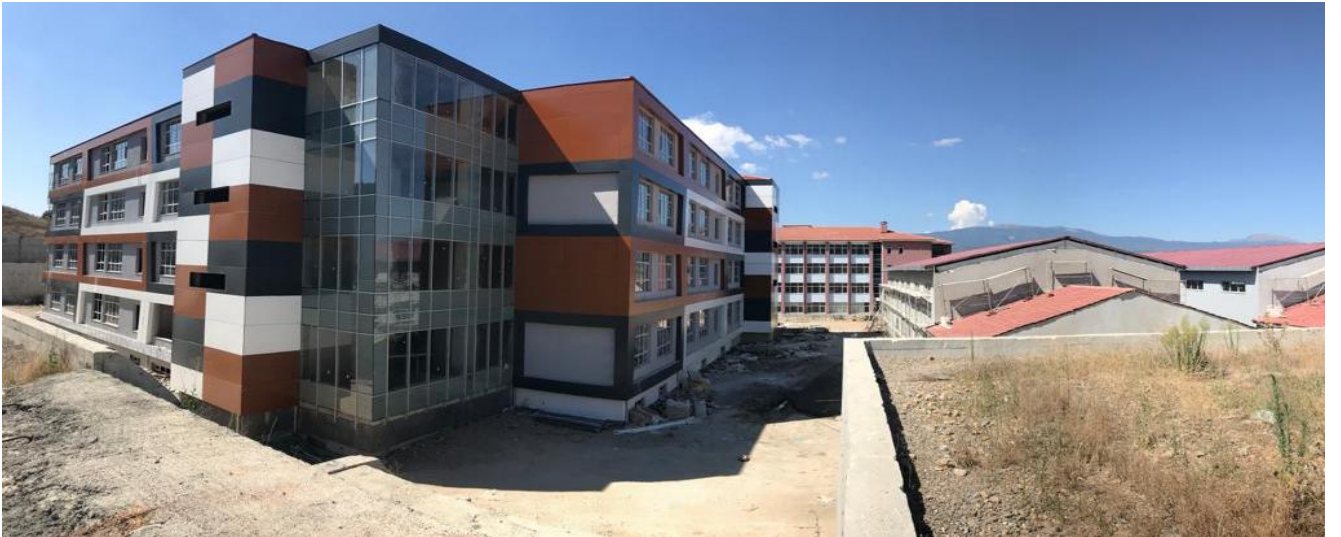
Bolu Merkez MTAL Atölye Binaları İkmal İnşaatı
