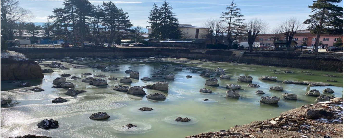
Bolu Merkez 100 Yataklı Uygulama Oteli Binası İnşaatı
