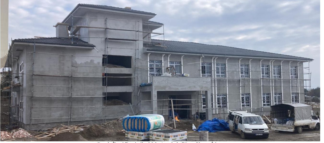
Gerde İlçesi Demirciler Mah. Anaokulu Binası Yapım İşi
