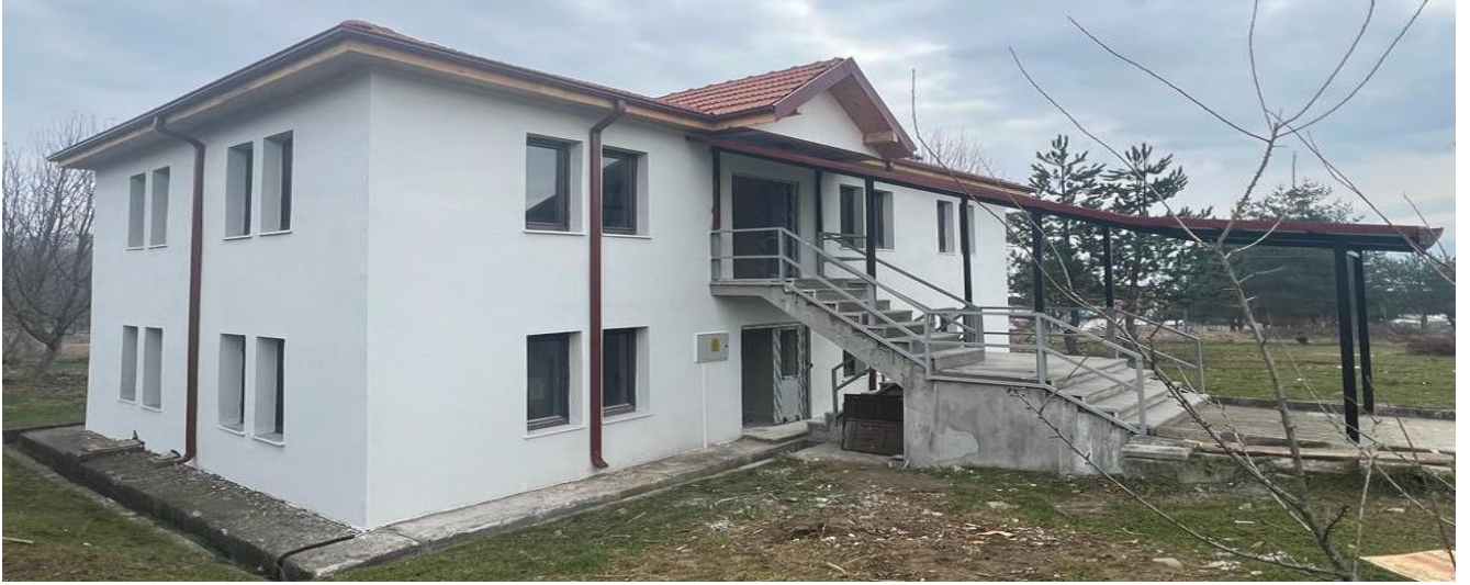
Bolu Dağı Jandarma Binaları Bakım ve Onarımı
