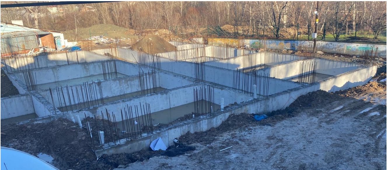
Göynük Dedeler Anaokulu Binası Yapım İşİ
