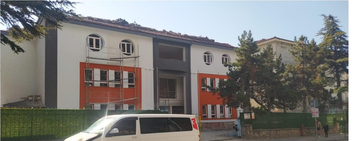
Sakarya İlkokulu Güçlendirme ve Onarım İşİ
