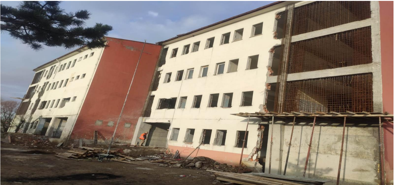
Gerede İlçesi Mesleki ve Teknik Eğitim Merkezi Binası
