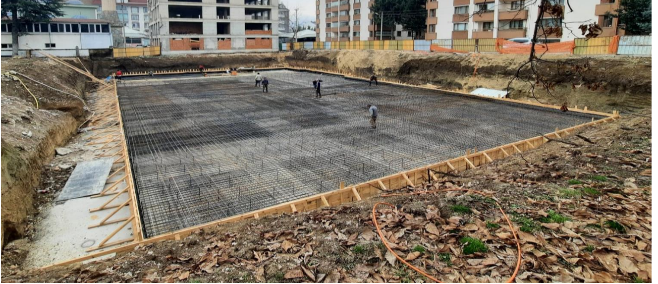
Bolu Merkez 100. Yıl Ortaokulu Binası Yapım İşİ
