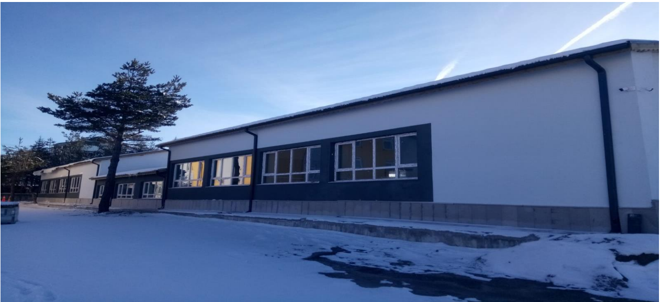
Gerede Mesleki Teknik Anadolu Lisesi Atölye Binası
