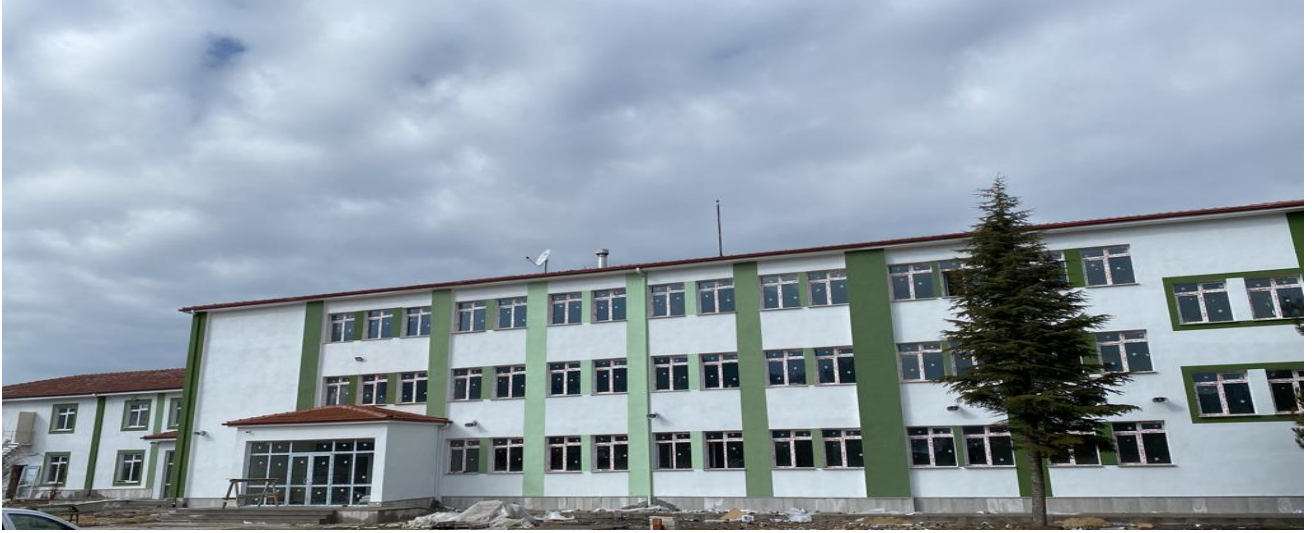
Aliçören Ortaokulu Güçlendirme ve Onarımı
