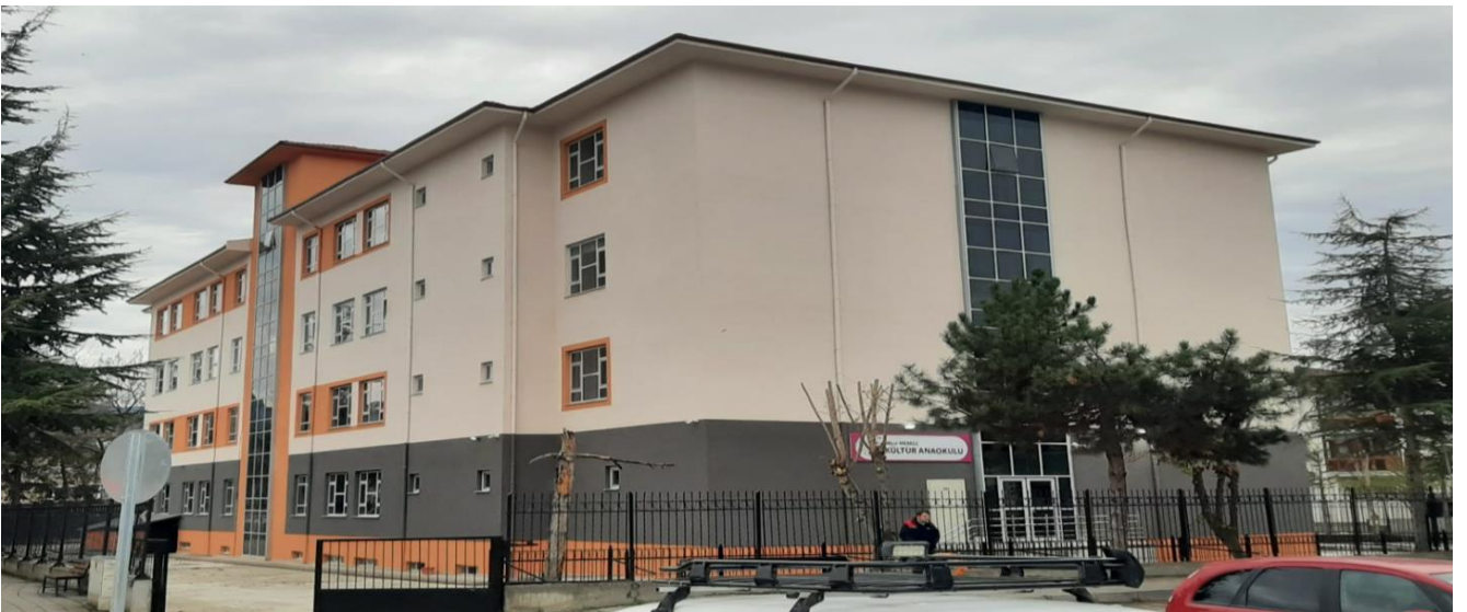
Bolu Merkez Kültür İlkokulu Binasi Yapım İşİ
